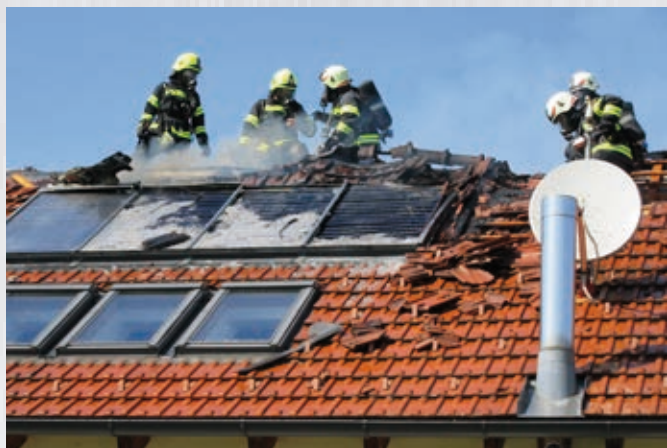
2018-04-21 Brand Wohnhaus Karl-Mayr-Straße
