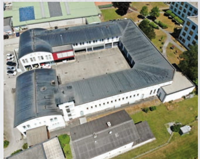
2023 Blick auf das Feuerwehrhaus von oben
