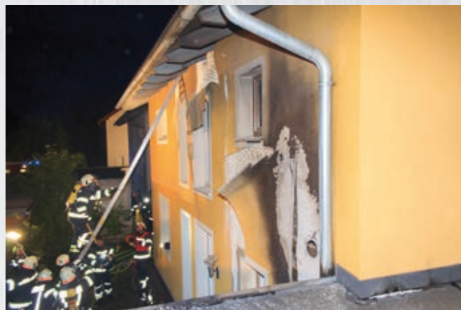
2020-07-12 Brand Wohnhaus Bachmannstraße
