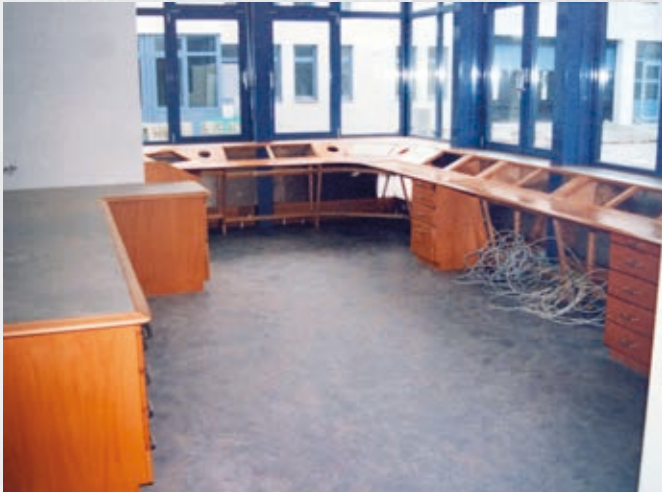
1992 Einbau der neuen Zentrale
