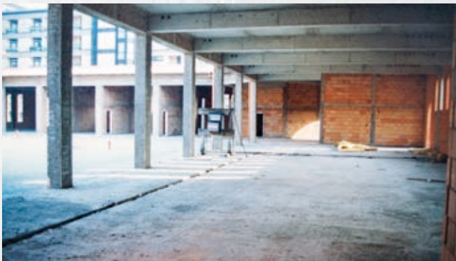
1992 Blick aus der Fahrzeughalle
